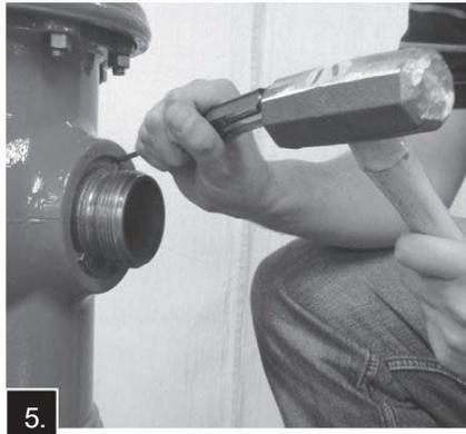
5. Retirez le capuchon de buse et la clé de buse. Placez le verrou de buse (pièce 143137) dans le sens de la longueur dans la fente formée par les pattes d'entraînement de buse et l'alésage du canon. Conduisez la buse A-316 Verrouillez en place en frappant plusieurs fois l'outil d'installation de verrouillage de buse avec un marteau en laiton lourd.
