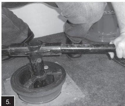
5. Serrez la vanne principale à 100-150 pi-lb. Retirez la clé de la tige en retirant l'axe de chape.
