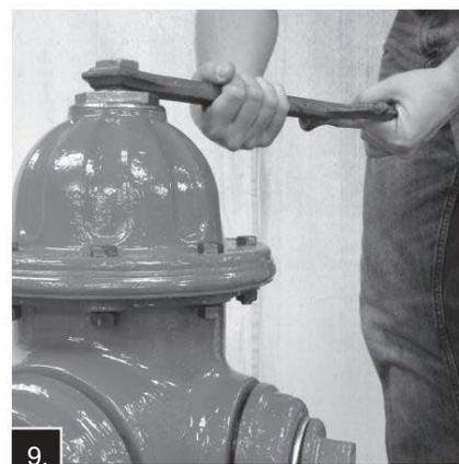
9. Tourner l'écrou de commande dans le sens de la fermeture pour s'assurer que la vanne principale est fermée fermement, puis tournez dans le sens de l'ouverture d'environ 1/4 de tour pour relâcher la tension sur le mécanisme de fonctionnement.
