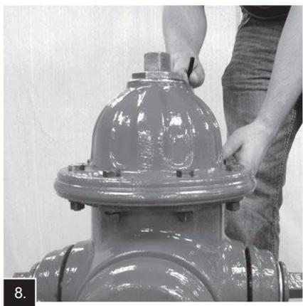
8. Retirez le bouchon de remplissage d'huile sur le côté du capot. Versez le lubrifiant MUELLER Hydrant dans le réservoir d'huile jusqu'à ce qu'il soit au niveau de l'orifice du bouchon de remplissage d'huile. Remplacez le bouchon de remplissage d'huile (voir la section Lubrification à la page 3).
