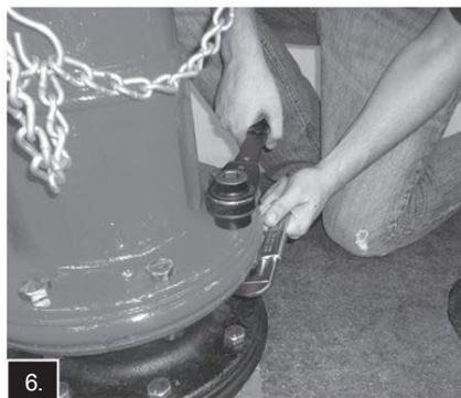
6. Remontez la tige supérieure à la tige inférieure. Placez le canon supérieur en place et remontez la bride de circulation.\* Serrez les boulons à 60 lb-pi.
