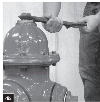
10. Tournez l'écrou de commande dans le sens de la fermeture pour vous assurer que la vanne principale est bien fermée, puis tournez dans le sens de l'ouverture d'environ 1/4 de tour pour relâcher la tension sur le mécanisme de commande.
