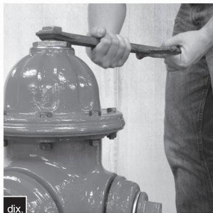
Tournez l'écrou de commande dans le sens de la fermeture pour vous assurer que la vanne principale est bien fermée, puis tournez dans le sens de l'ouverture d'environ 1/4 de tour pour relâcher la tension sur le mécanisme de commande.
