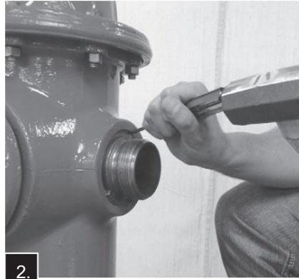
2. Retirez le verrou de buse en acier inoxydable en le chassant avec un outil pointu et un marteau.
